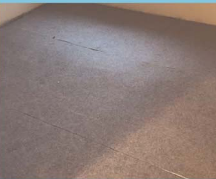
5. 隔音墊銜接處平接密貼
