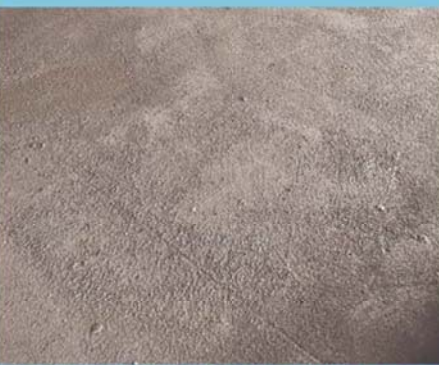
8. 第二黏著劑固化完成(專利工法)
