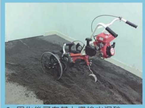
9. 固化後可在其上攪拌水泥砂 (材質強韌之隔音墊方可使用)
