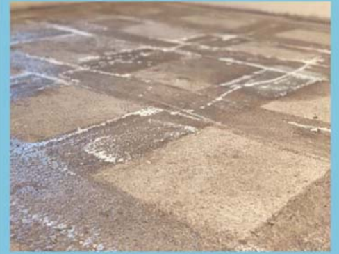
3. 樓板塗佈第一黏著劑(A膠)
