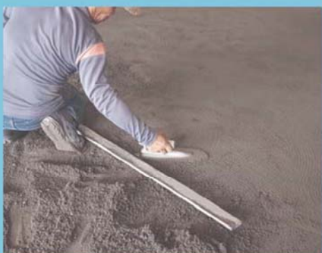
10. 水泥砂打底施工
