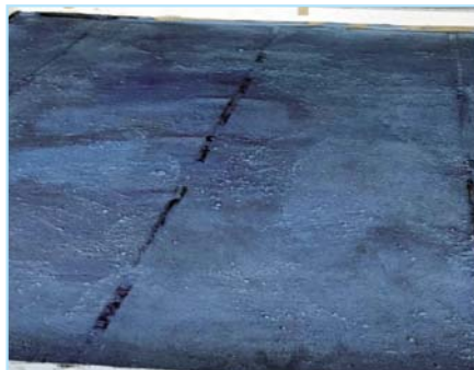
8. 第二黏著劑全面塗佈 (專利工法)
