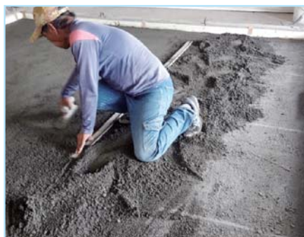
11. 磁磚水泥砂打底施工
