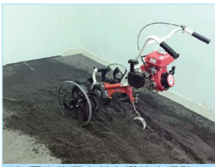
10. 固化後可在其上攪拌水泥砂 (材質強韌之隔音墊方可使用)
