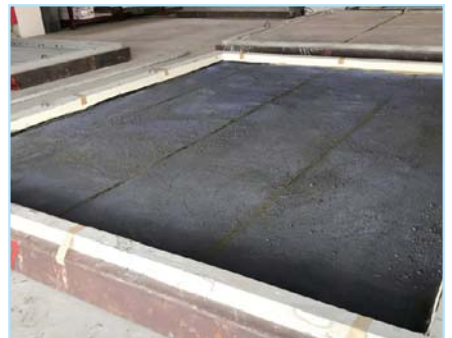
9. 隔音墊表面固化完成 (專利工法)
